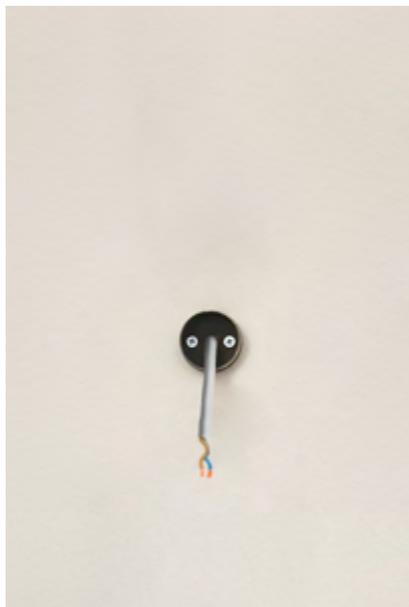
Passare i cavi e fissare il supporto del rosone multiplo.
