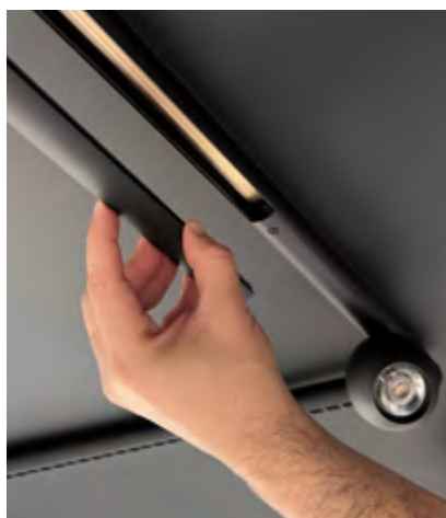
Cortar el accesorio de cobertura del carril a medida, teniendo en cuenta el número de proyectores instalados.
