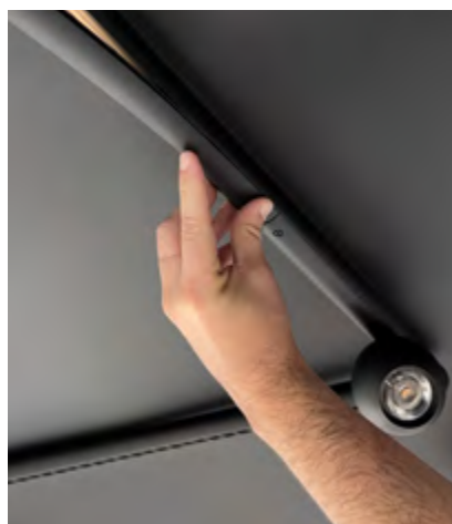
Colocar la cobertura cerrando las partes descubiertas del módulo de carril electrificado.
