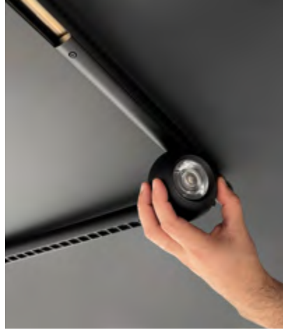
Einsetzen des Scheinwerfers in das elektrifizierte Schienenmodul.
