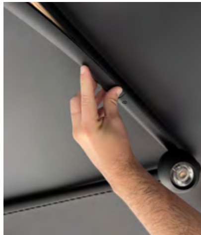
Die Abdeckung so anbringen, dass die freiliegenden Teile des elektrifizierten Schienenmoduls abgedeckt werden.
