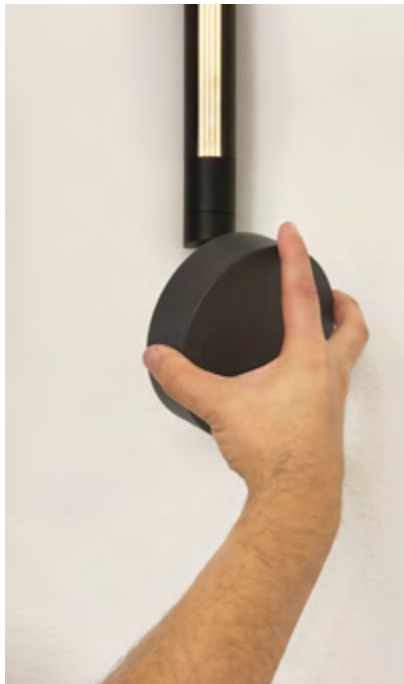
Die Mehrfachrosette an die Befestigungshalterung annähern.
